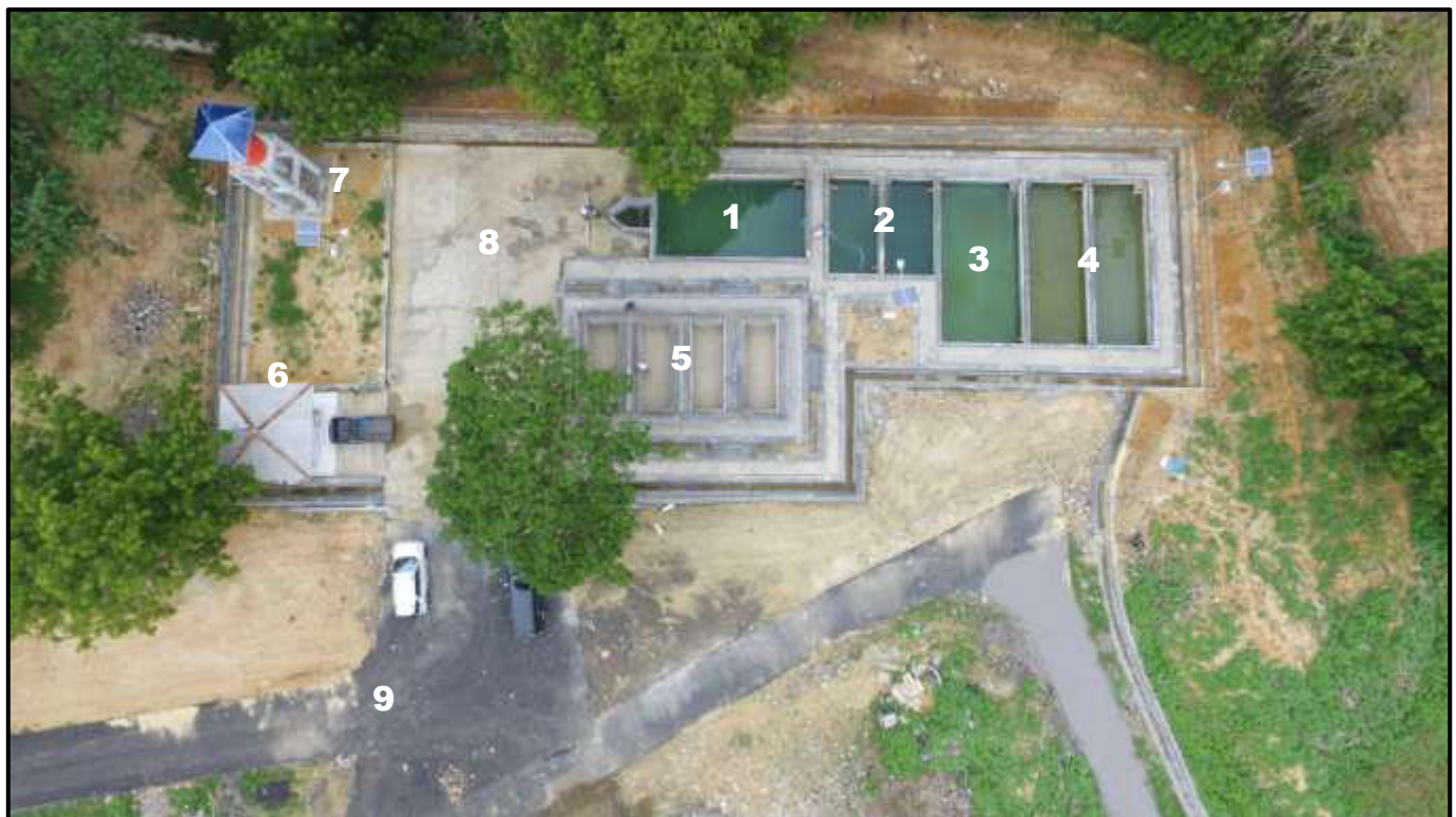
Sumber: Laporan Pembangunan IPLT, 2016
